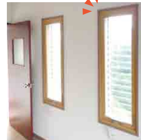
ルーバータイプのダブルガラスは、 通気も断熱も叶う優れたものです。
