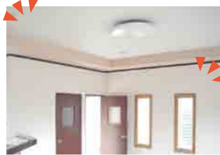
壁・天井 クロス張り替え
