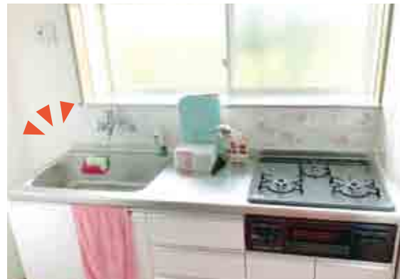
システムキッチン交換
