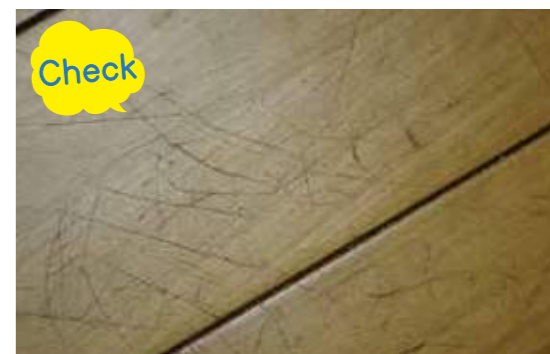
一般的な木材フローリングは、ひっかき傷が目立ちます。
