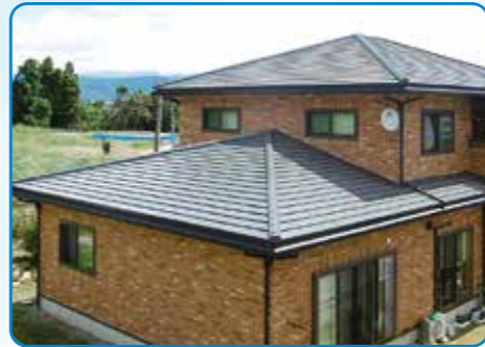
【修繕】【葺き替え】
